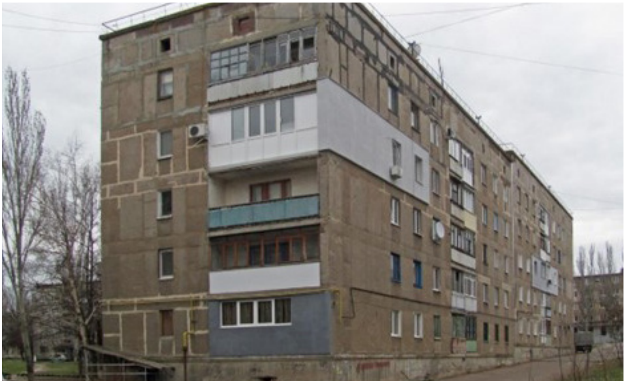
Рисунок 2.6. Вигляд стін багатоквартирного крупноблочного будинку (м. Бахмут)
